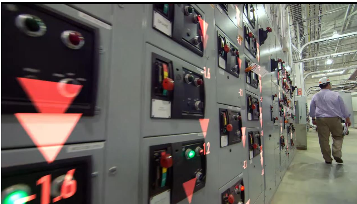
Slika 289.- Provera ispravnosti svih neophodnih parametara nakon puštanja postrojenja u rad [web.103]
