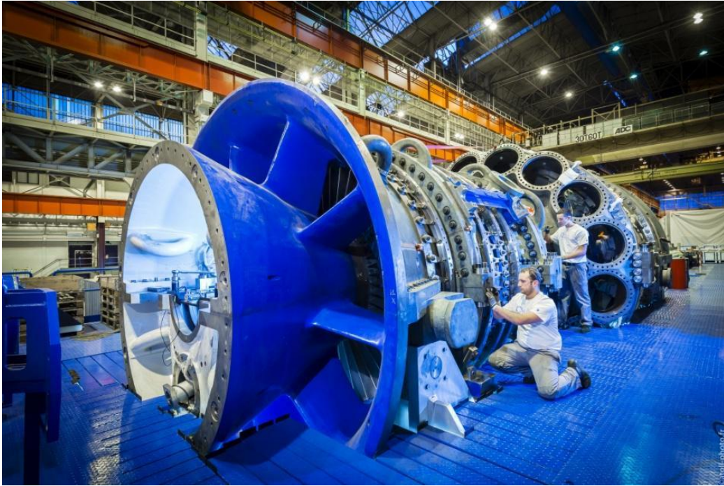
Slika 287.- Proces ugradnje gasne turbine 9HA kompanije GE [web.92]
