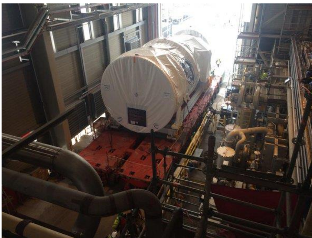
Slika 283.- Istovar gasne turbine 9HA u elektranu EDF Bouchain [web.92]
