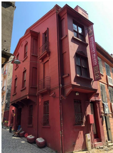
Sl.1. Muzej nevinosti - zgrada
