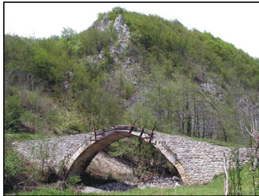
Слика 49. Стари мост на Љубовићи Фото: М. Ивановић
