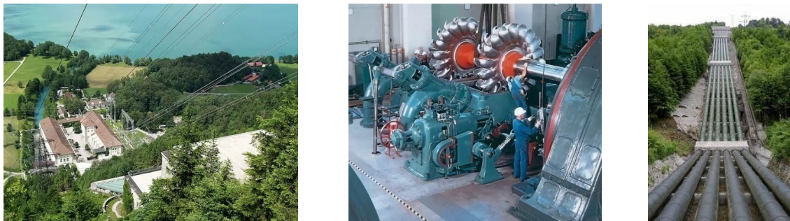
Слике 282., 283. и 284. Детаљи из Електричне централе Walchensee Извор: www.erih.net
