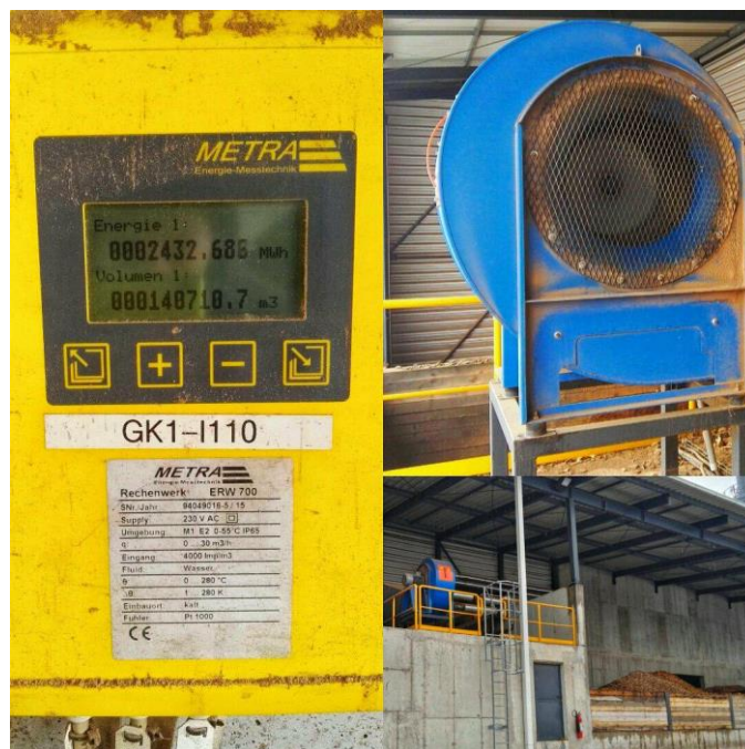
Слика 5.7 Калориметар у непосредној близини предгрејача ваздуха за сушење и вентилатора
