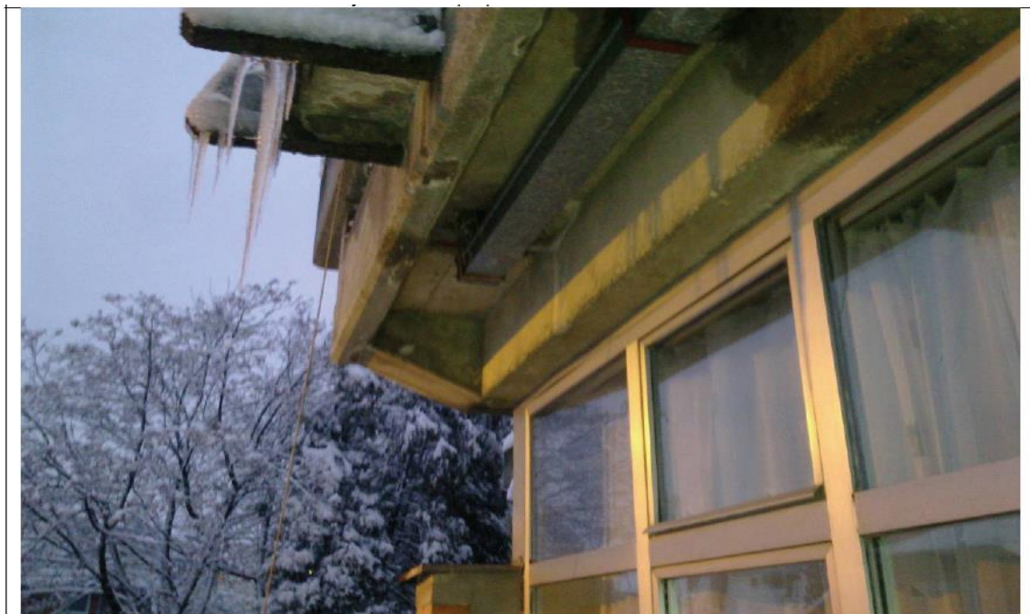
Слика 13.2. Фотографија препуста изнад терасе са хоризонталним олуком
