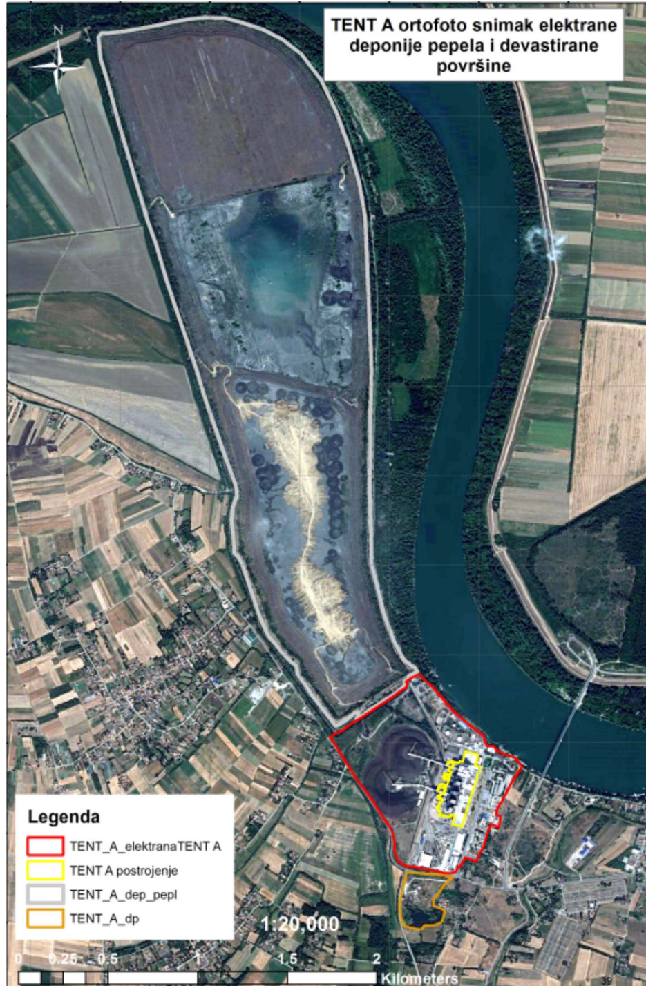
Слика 13. Ортофото снимак електране, депоније и девастиране површине ТЕНТ „А“
