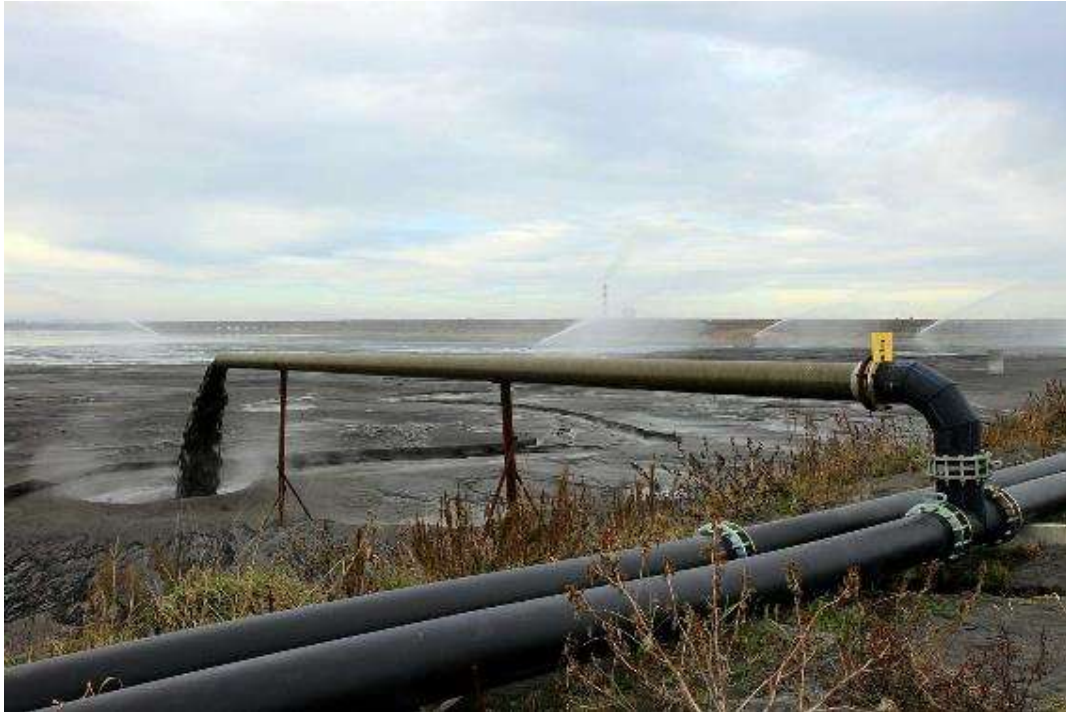
Слика 14. Нови систем одвођења пепела из ТЕНТ „Б“ на активну касету (Преузето са: https://staklenozvono.rs/2010/12/novi-sistem-prikupljanja-i-odlaganja-pepela-u-tent-u/ )
