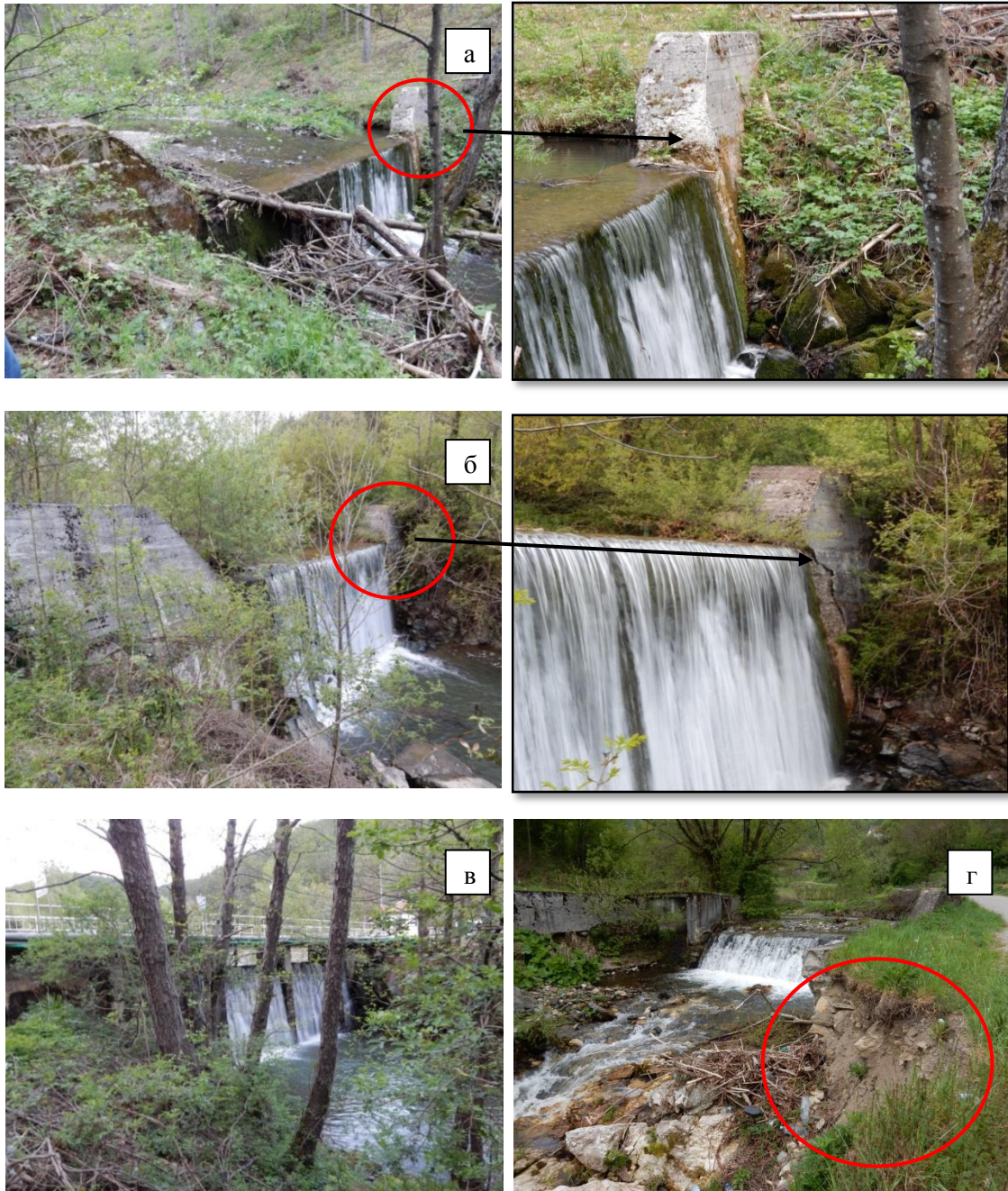
Фототаблица 3: а) преграда бр. 2 у Загржи са детаљем оштећења, б) преграда у потоку Кривача, са детаљем оштећења, в) преграда бр. 1 у Загржи, г) преграда у Расини (Бзенице)
