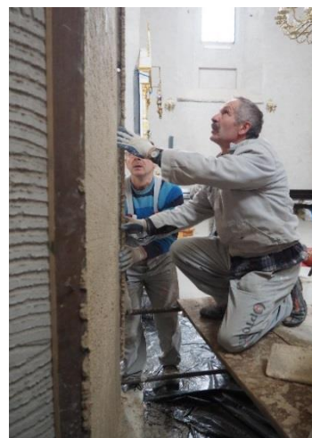
Сл. 73. Наношење малтера први слој, североисточни стуб, Благовештењска црква у Супрасл, Пољска, 2016.
