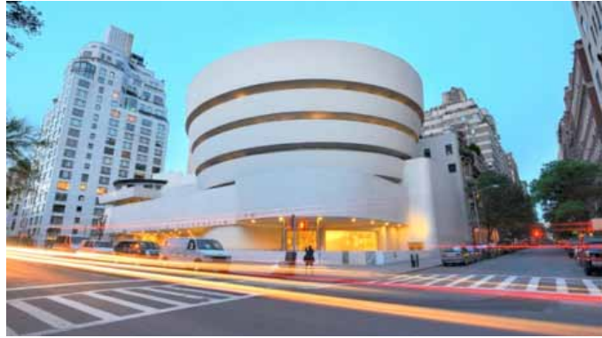
Слика 88, Гугенхајм музеј, Њујорк
