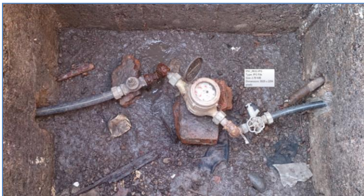
Slika 148 Primer sistemskog snimanja kućnih priključaka i unošenja podataka u GIS – fotografija vodomernog šahta sa detaljima kućnog priključka
