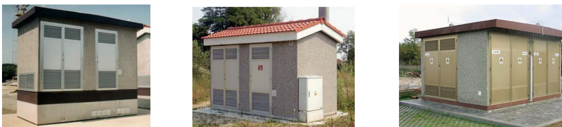
Slika 28. Armiranobetonske montažne transformatorske stanice
