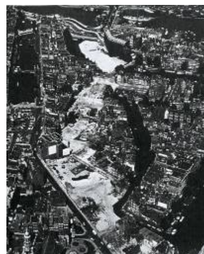
Slika 82. Nieuwmarkt, Amsterdam, srušeno područje zbog izgradnje podzemne stanice
