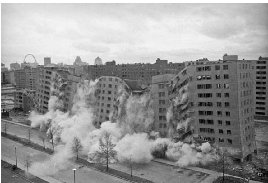
Slika 22. Rušenje Pruitt-Igoe projekta, St. Luis, 1972
