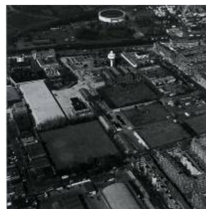
Slika 86. Prostor stare fabrike vode, Amsterdam
