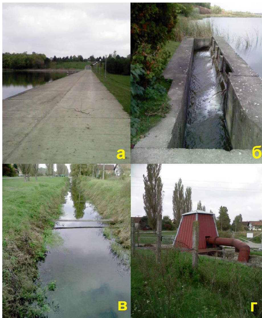
Слика 14: Акумулационо језеро Стара Моравица а) Круна бране и узводна облога бране; б) преливни орган; в) Канал К-23, узводно од акумулације; г) Црпна станица Моравица II (аутор фотографија Ратко Бајчетић)
