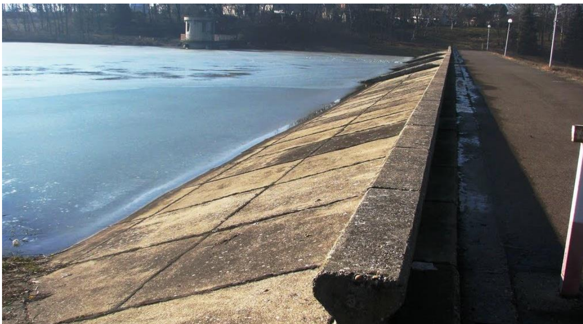
Слика 13: Круна бране и узводна облога бране акумулационог језера Панонија (преузето из Фото документације ЈВП 'Воде Војводине', аутор фотографије: Бранислав Лакићевић)
