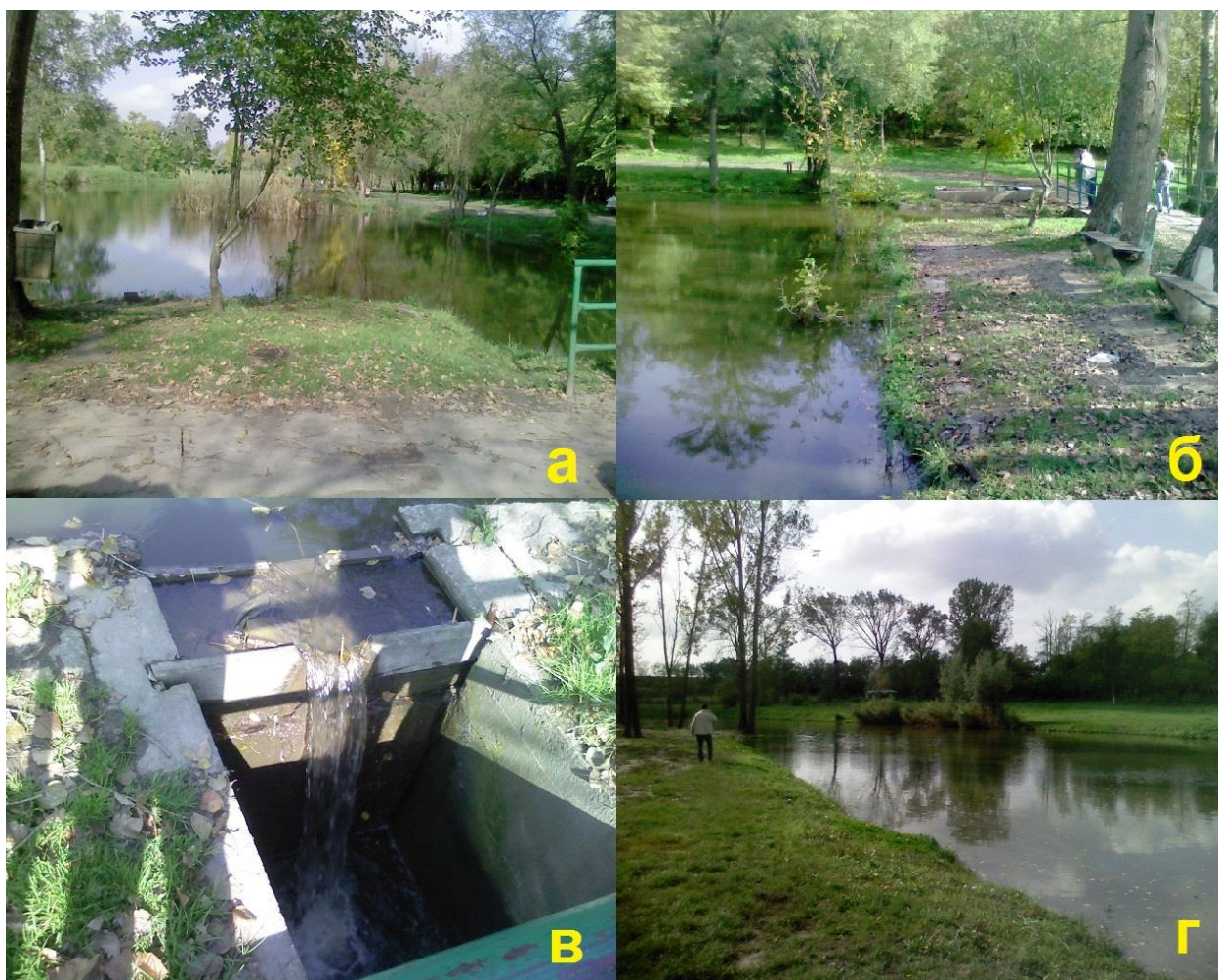
Слика 16: Акумулација (микро-акумулација) Багремар – а) поглед на акумулационо језеро и излетиште са круне бране; б) круна земљане бране акумулације Багремар; в) евакуациони орган – гредичаста устава (загат) са слободним преливањем; г) поглед на акумулацију (аутор фотографије: Ратко Бајчетић)
