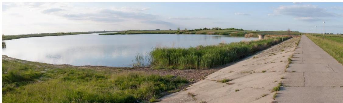
Слика 15: Круна бране и узводна облога бране, са погледом на акумулационо језеро Таванкут-Скендерово (преузето са: Google Earth, аутор фотографије: Калмар Роберт)
