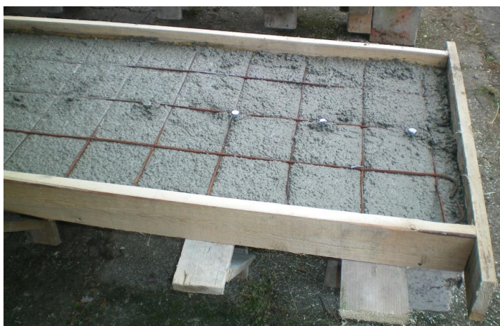
Slika 5.4. Izrada betonske ploče nosača
