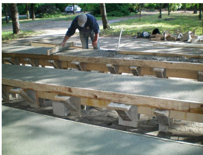
Slika 5.5. Izrada spregnutih nosača
