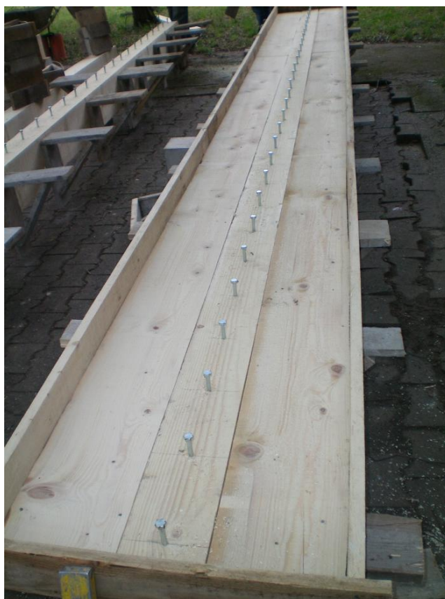
Slika 5.3. Raspored zavrtnjeva u nosaču
