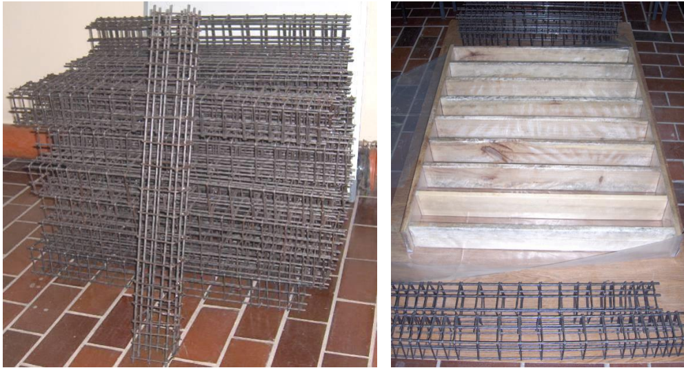
Slika 8.1 Pripremljena armatura i oplata stubova
