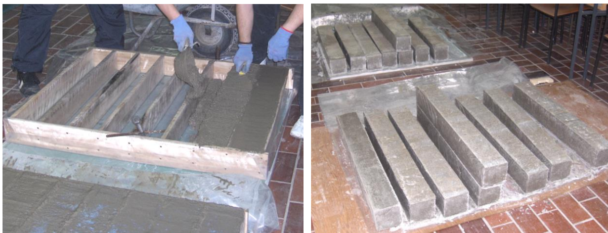
Slika 3.10 Betoniranje i stubovi nakon skidanja oplata
