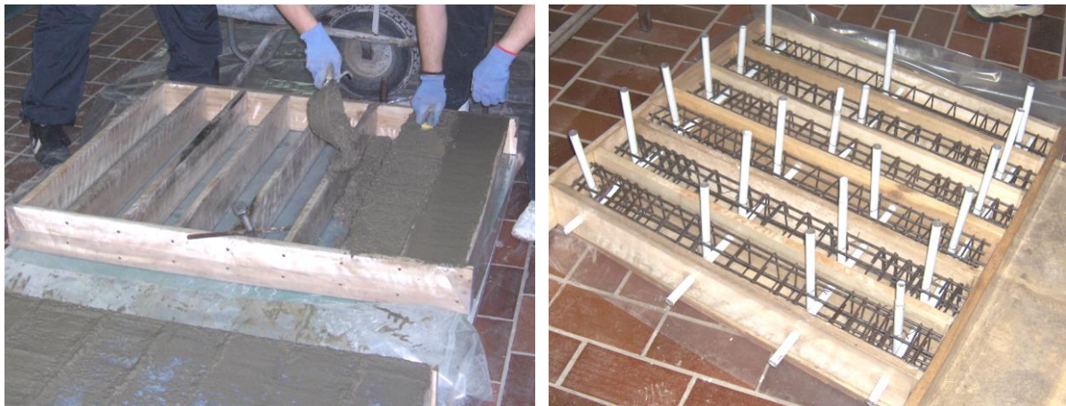
Slika 8.2 Betoniranje stubova i oplata namenjena modelima koji se ojačavaju VV zavrtnjima
