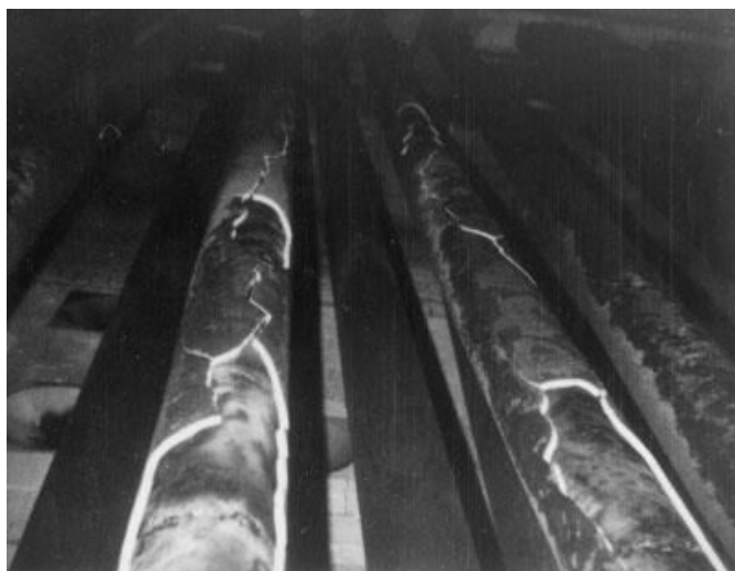
Slika 3.3.6. Izgled oštećenih cevi – krt lom
