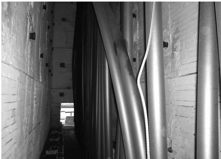
Slika 3.3.16. Izduženje usled puzanja rezultuje krivljenjem cevi zbog toga što su cevi stigle do kraja vođica i dodirnule pod peći (13)
