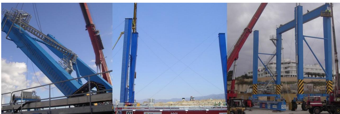
Слика 5.6. Пример процеса усправљања РТГ дизалице на терминалу
