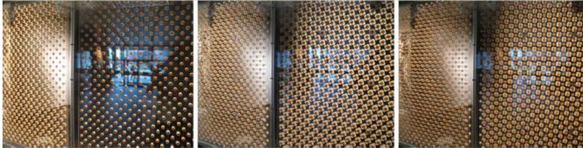
Сл.64 Приказ различитих фаза "фритовања" површине структуре и њене провидности (Фотографије прилога сл 1.59. преузете са http://www.adaptivebuildings.com/adaptive-fritting.html , у књизи (фуснота 108 ), А. Фотиадоу прилог на страни 29.)
