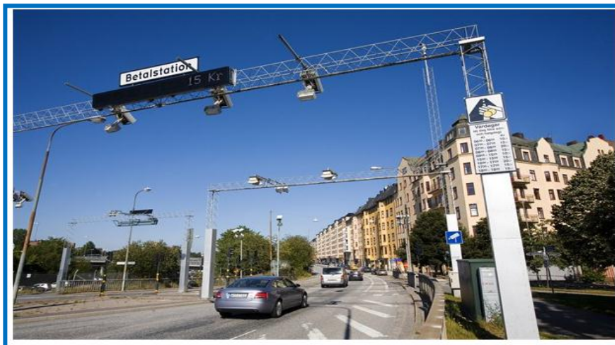
Слика бр. 2. Уређаји који региструју улазак аутомобила у зону у којој се плаћа порез на загушење саобраћаја у Стокхолму
