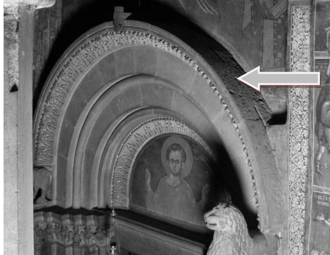
Слика 10.18. Трагови рупа од подизања помоћу троделних чедова по средини сводара (Преузето са: http://www.srpskoblag.org/Archives/Decani/exhibits/Frescoes/Narthex/CentralNave/EastDome/CX4K3324.html , Датум приступа: 1.04.2012.год.)
