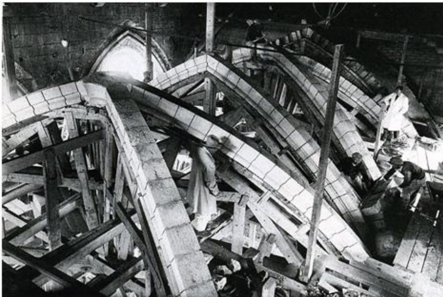
Слика 10.40. Реконструкција сводова на катедрали у Соасону после Првог светског рата: На десној страни су два мајстора која ослањају редове једног сегмента о трансверзални лук и дијагонални лук тј. ребро (према: Wilson С., 2000)
