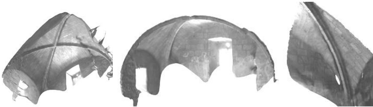
Слика 10.32. Фотограметријски снимак свода припрате Богородичине цркве у Градцу (1271): перспективни приказ, пресек кроз дијагонално ребро, детаљ ребра
