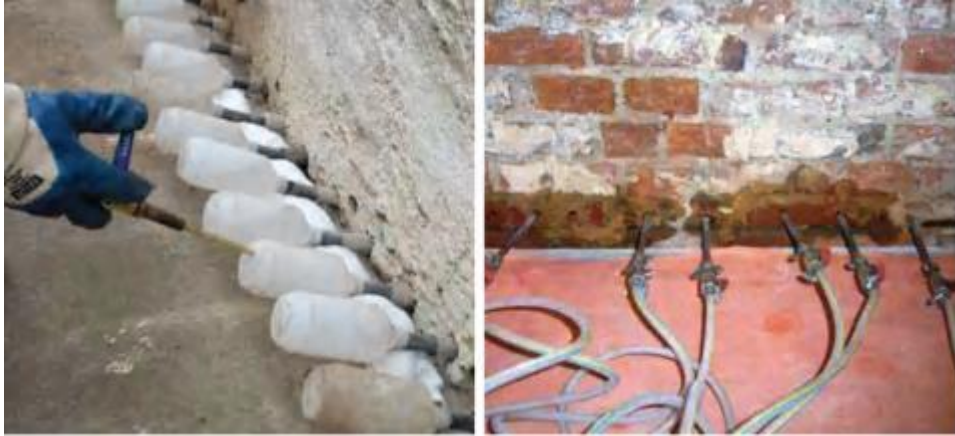
Slika 13. Postupak ulivanja odgovarajućeg sredstva za hemijsku impregnaciju[10]
