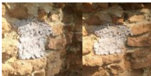
Slika 64. Primena odabranog bioaktivnog sistema u realnim uslovima
