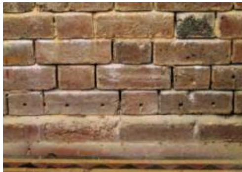
Slika 14. Proces degradacije opeka dejstvom rastvorljivih soli iznad vodo-nepropusne zone nakon postupka hemijske impregnacije [10]
