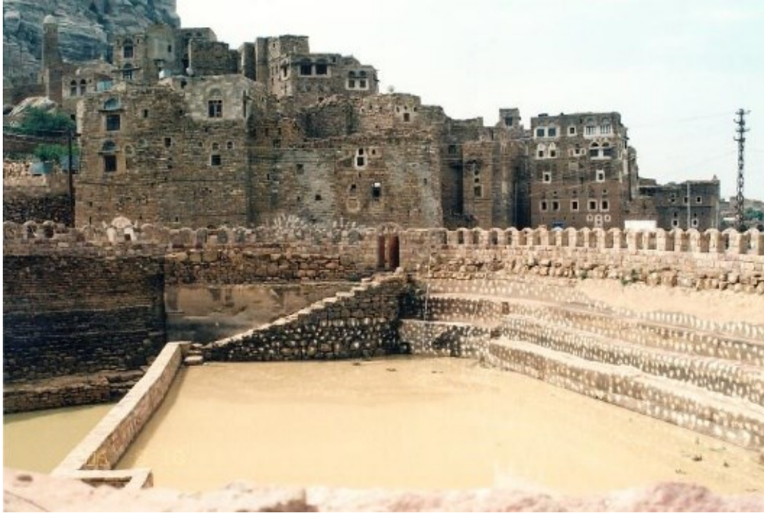
Слика 3. Резервоар за воду у граду Тила. Тврђава Хусн ал-Гураб је на врху литице чије се подножје види у горњем левом углу. 22
