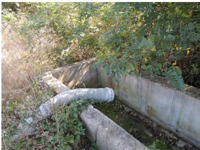
Слика 2.8 - Ободни канали за прикупљање и евакуацију атмосферских падавина на несанитарној депонији "Бубањ" у Нишу [23]
