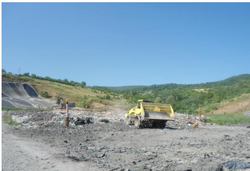
Слика. 4.24 - Пасивни систем за дегазацију депонијског гаса на регионалној санитарној депонији "Мунтина падина" у Пироту
