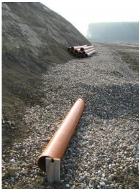
Слика 2.7 - Постављање цеви за дренажу подземних вода на регионалној санитарној депонији "Срем-Мачва" у Шапцу и Сремској Митровици [103]
