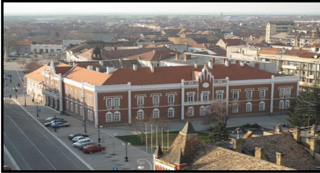
Слика 8. Градска скупштина у Вршцу Извор: http://evrsac.rs/
