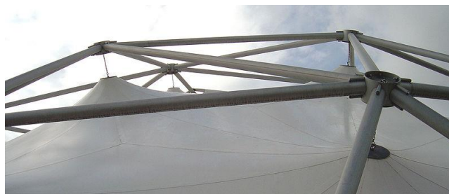
Слика 4-4) Детаљ везе мембране и геодезијске куполе
