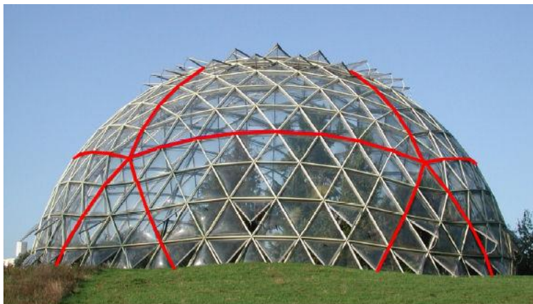
Слика 4-10) Икосаедарска геодезијска купола фреквенције 8v
