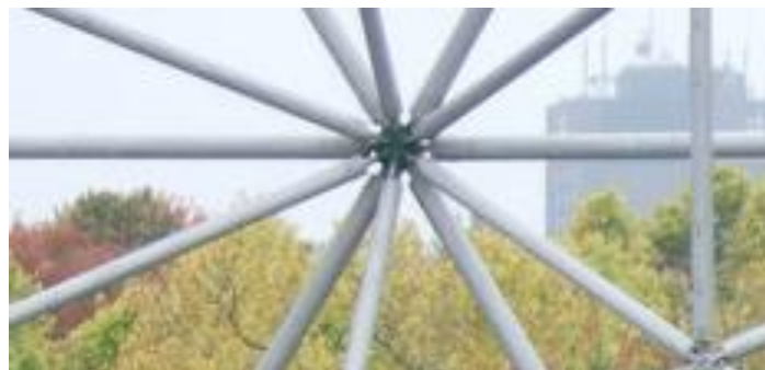
Слика 4-13) Чворна веза штапова геодезијске куполе у Монтреалу
