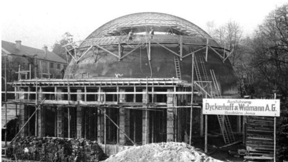
Слика 4-1) Планетаријум Јена, Немачка; пресвлачење носиве структуре бетоном 30
