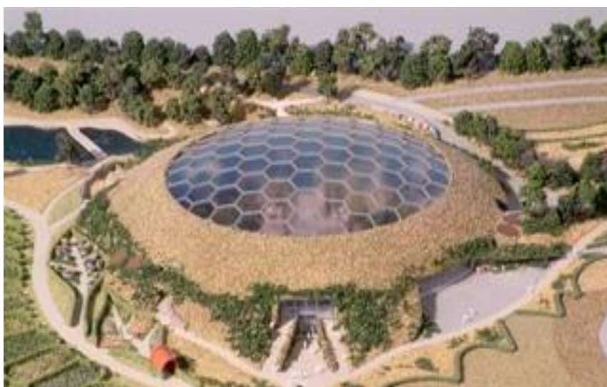
Слика 5-1) Закривљена теселација равни над кружним прстеном
