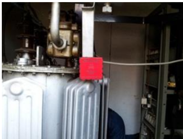
Slika 3.41. Kontaminirani transformator
