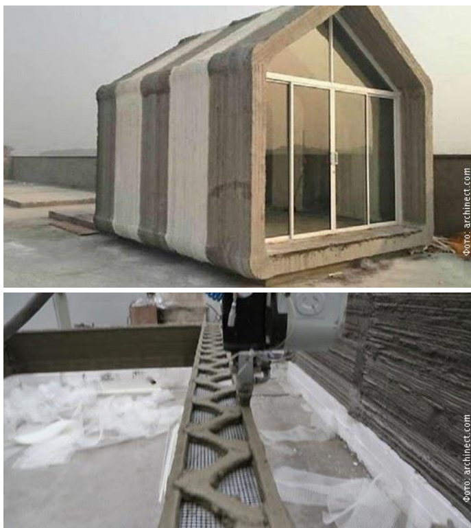
Слика 30: 3D штампана кућа, процес – машина и материјал, Кина
