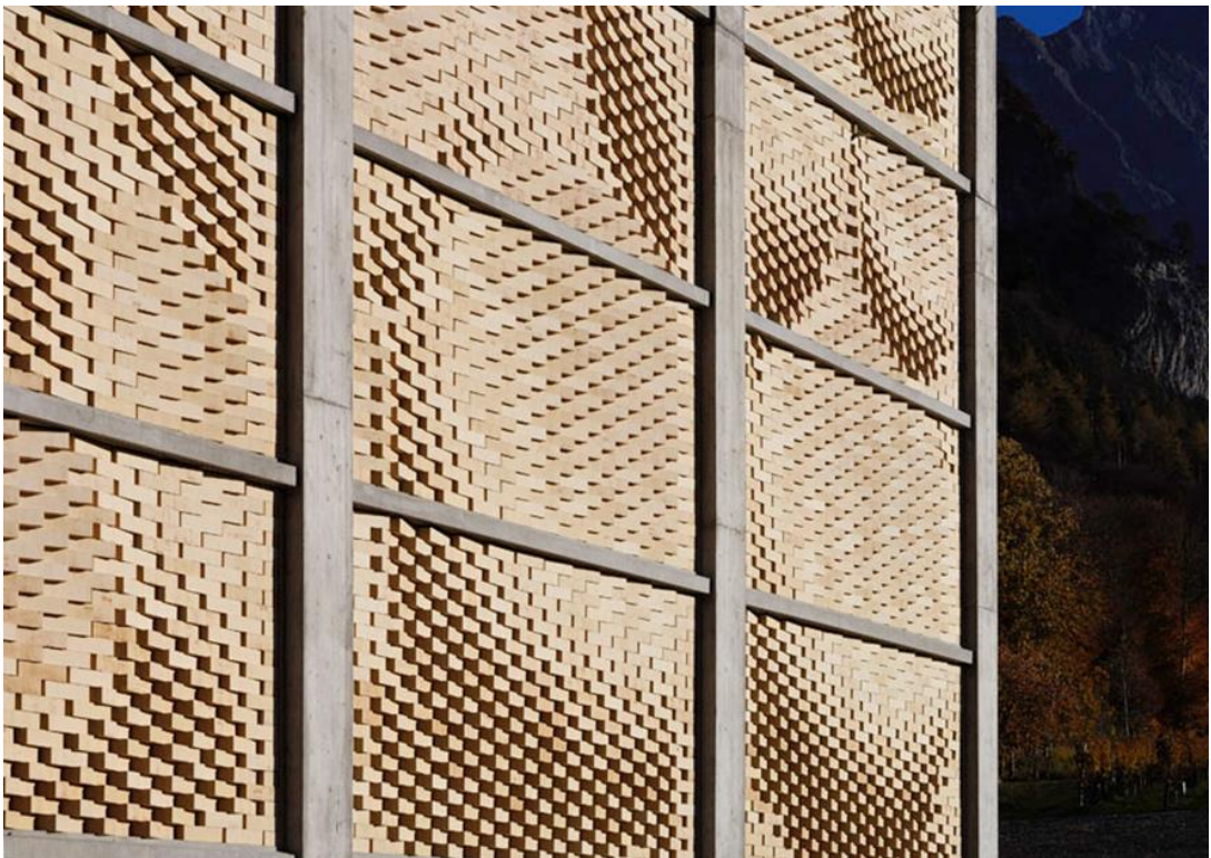
Слика 59: Винарија, зид од нестандардизованог слога опеке (фасада)
