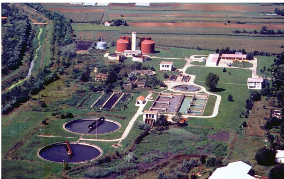
Slika 43. Uređaj za prečišćavanje otpadnih voda - Sombor ( http://www.vodokanal.co.rs/ , pristupljeno 28.05.2015.)
