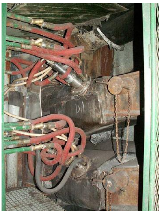
Слика 1.4 Приказ уграђених плазматрона на горионичким каналима
