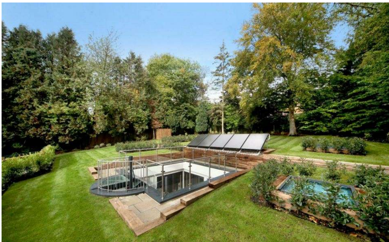
Сл 226. Соларни колектори као комбиновани систем снабдевања енергијом ПСО
