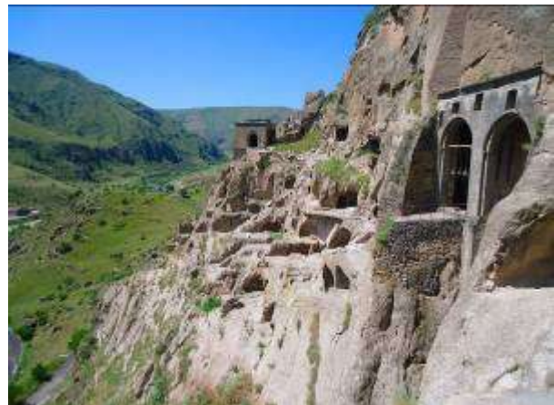
Сл.41. Изглед пећинских подземних објеката 2
