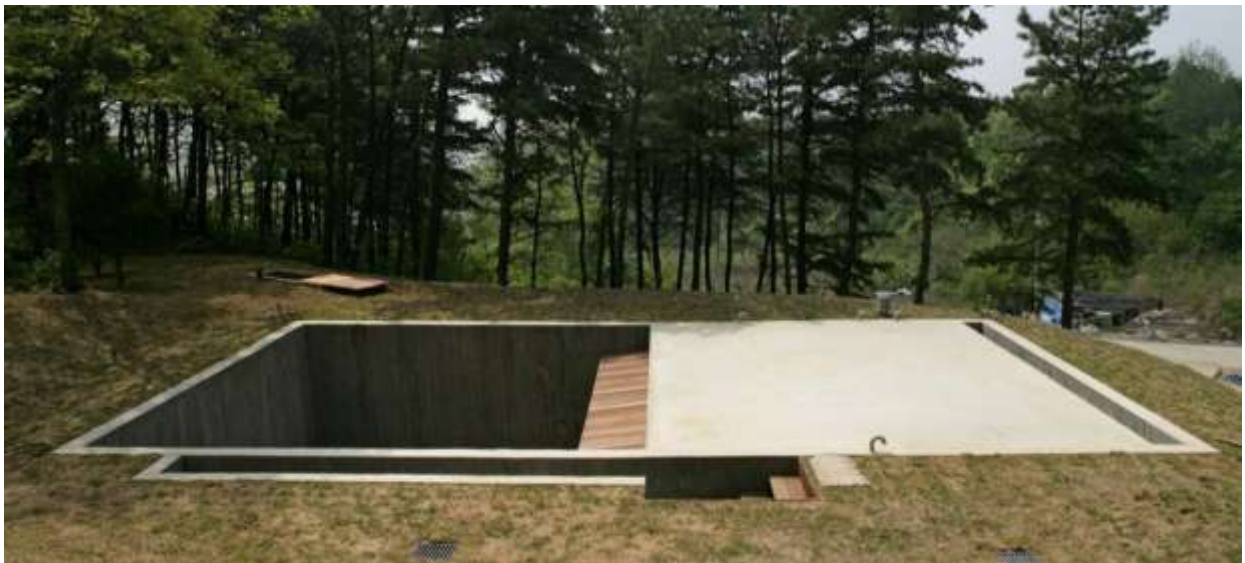
Сл.268. Изглед подземног - укопаног стамбеног објекта
