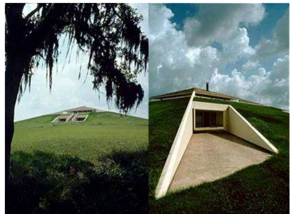
Сл.131. Изглед објекта
