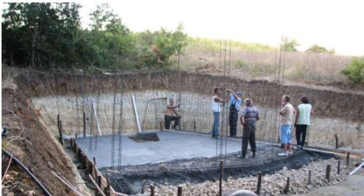
Сл.314. Почетак изградње уз наливање темељне плоче Објекта 1 / 2008.год.
