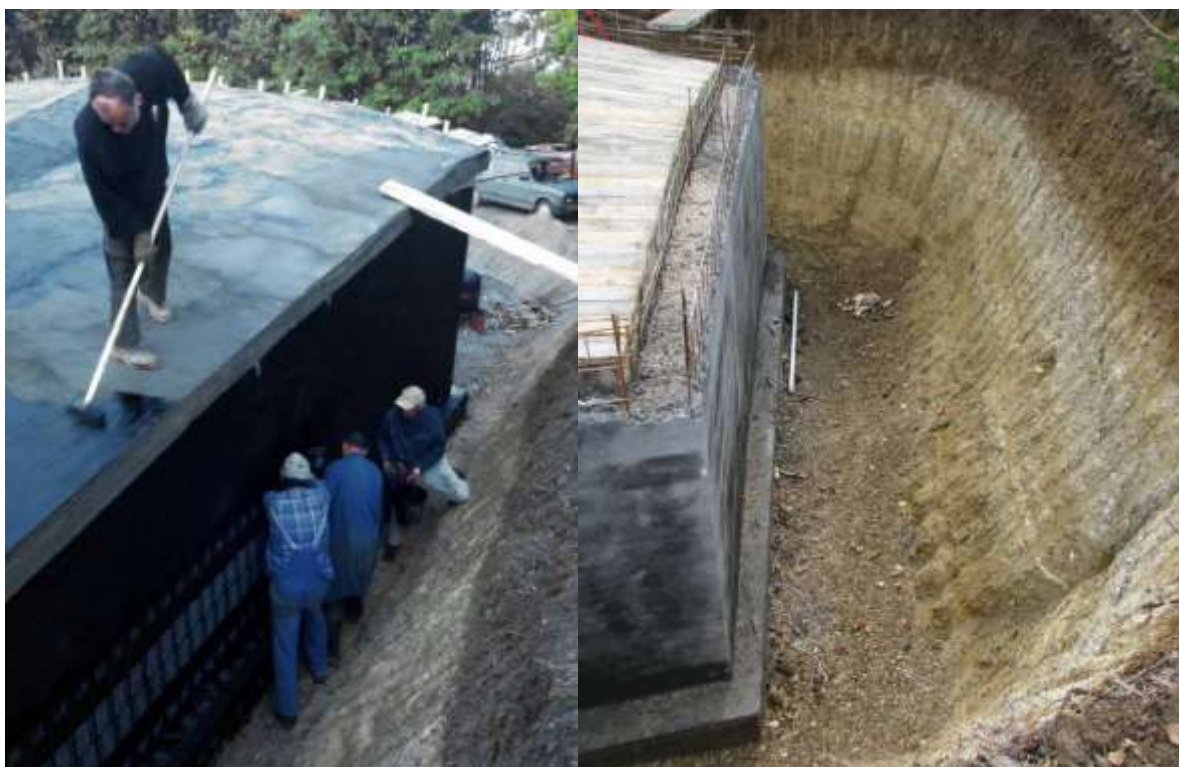
Сл.316. Израда изолације на кровној плочи и зидовима око Објекта 1
