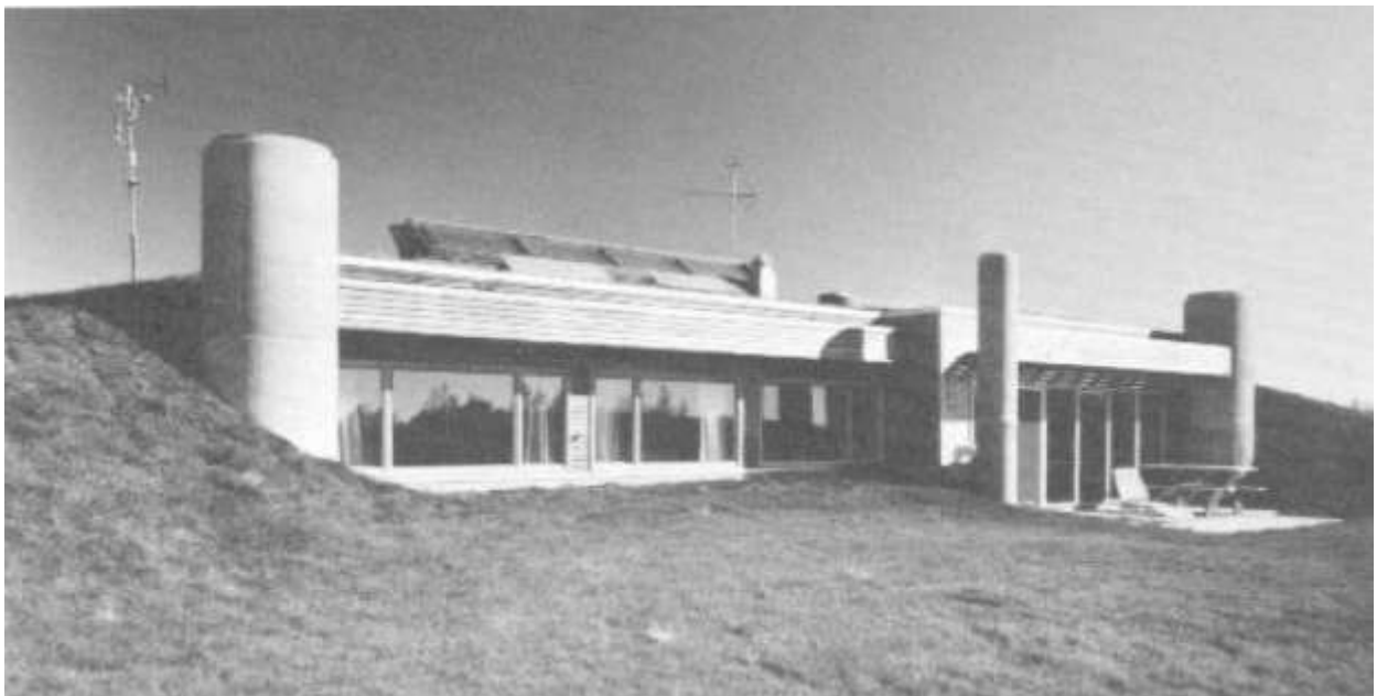
Сл. 232. Изглед подземни стамбени објекат Камден Стејт Парк, Линд, Минесота, САД
