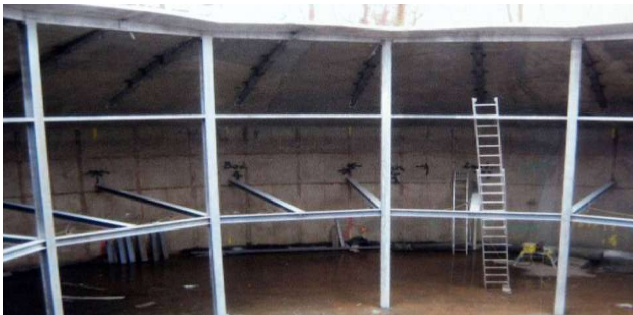
Сл.338. Некадашњи изглед резервора за воду
