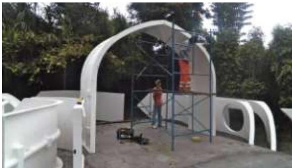
Сл.165. Фаза постављања префабрикованих елемената
