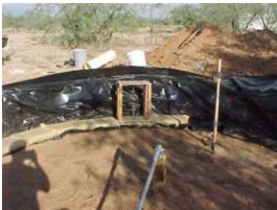
Сл 158. Изградња укопаног дела објекта типа - Кошница
