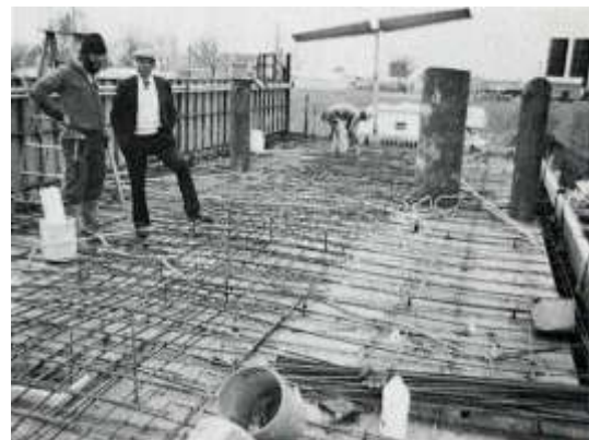
Сл.157. Фаза бетонских радова 3
