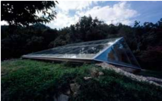
Сл.239.Изглед крова објекта
