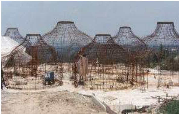
Сл.147. Постављање арматуре куће Блек Стоук, Онтарио, Канада
