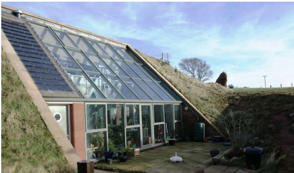
Сл.247. Изглед - јужна фасада објекта
