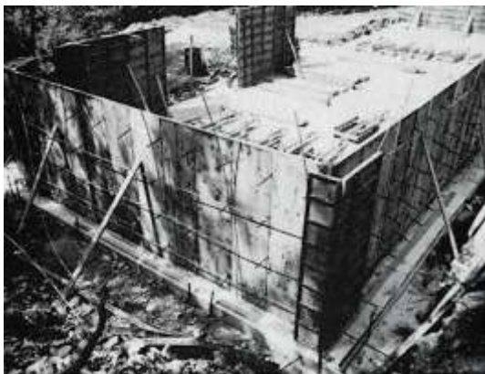
Сл.156. Фаза бетонских радова2
