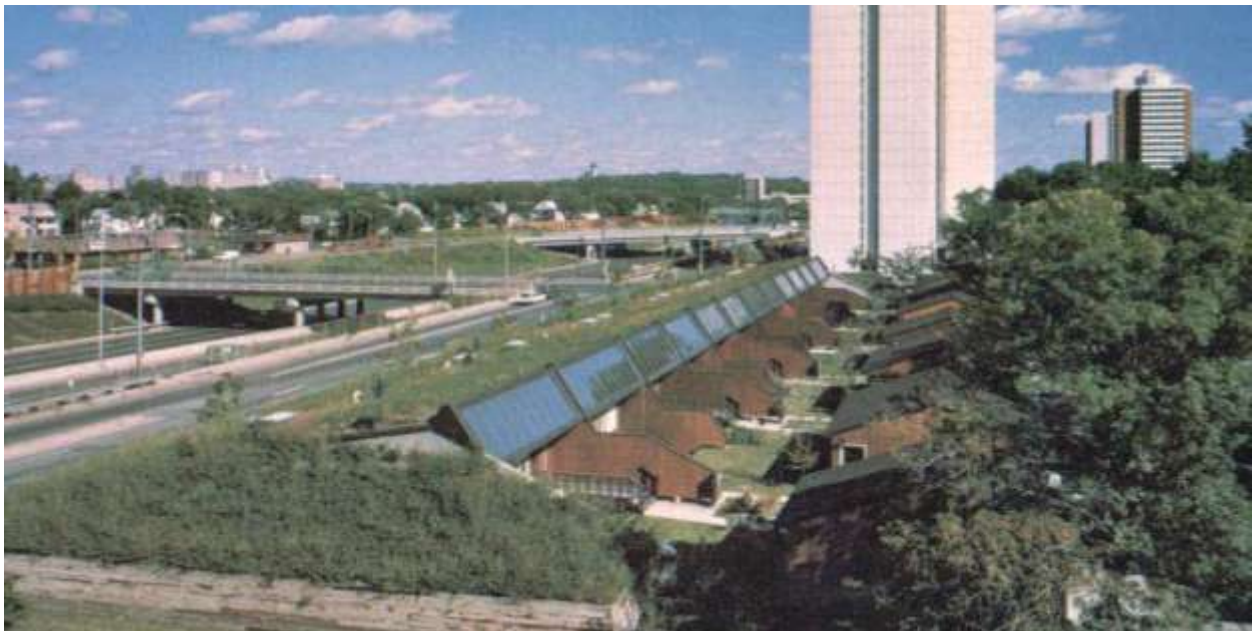
Сл.182. Подземни градски стамбени објекти у насељу Суард, Минеаполис, Минесота, САД
