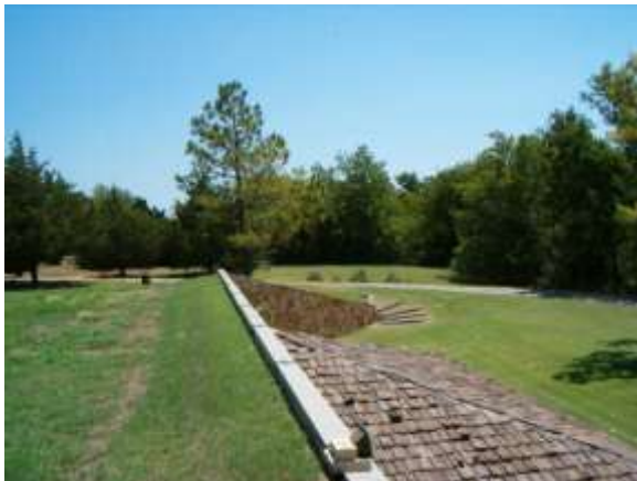
Сл.128. Изглед крова насуте куће у Оклахоми, САД
