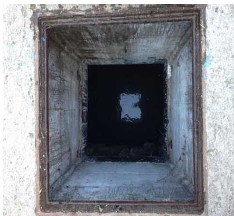
Slika 22. Levi gradski kolektor niškog kanalizacionog sistema 122
