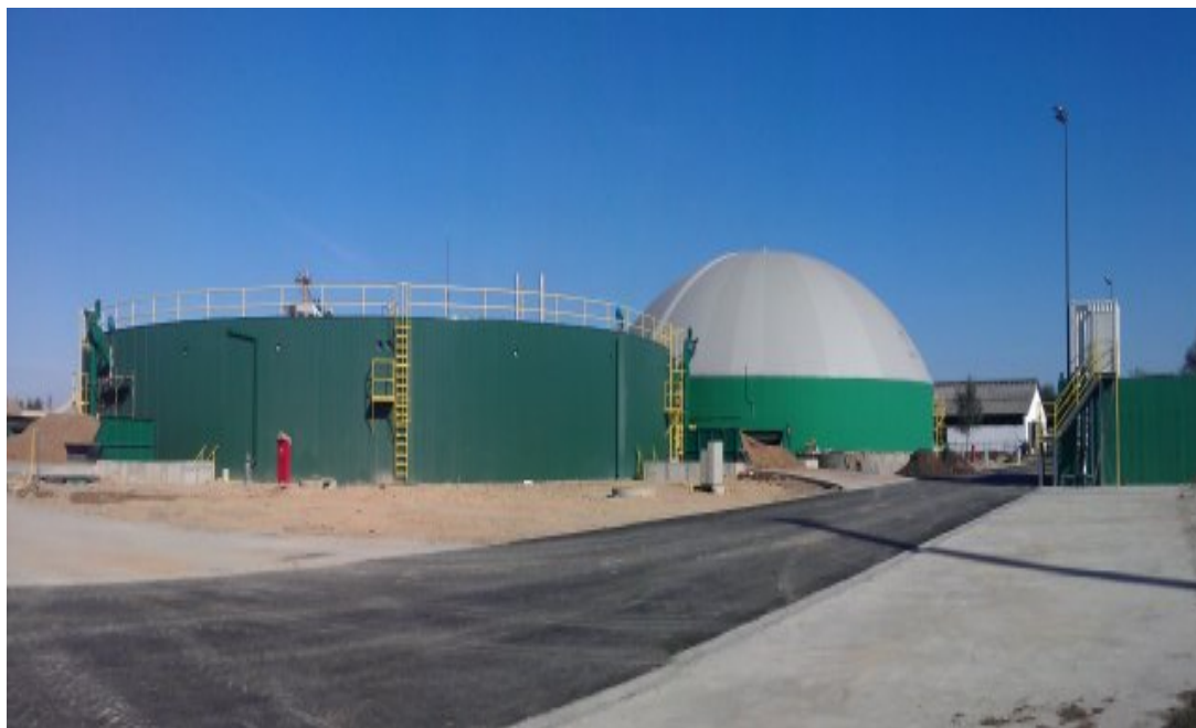
Slika 3.5 Biogas postrojenje Mirotin u Vrbasu
