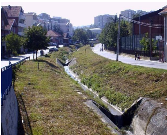
Слика 24 Миријевски каналисани поток
