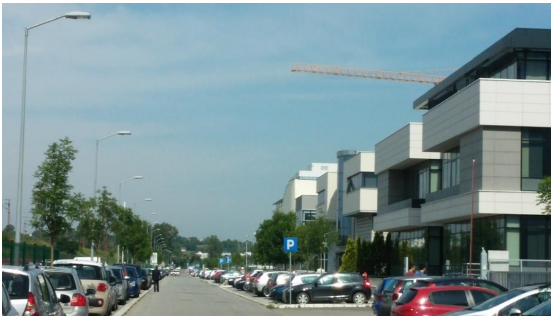
Slika 48. Testna instalacija u Ul. Milutina Milankovića posmatrana od Hotela „Holiday Inn“ u pravcu poslovnog centra „GTC Square“ i raskrsnice sa Ul. Omladinskih brigada – u prvom planu vide se NaVP svetiljke ONYX 2
