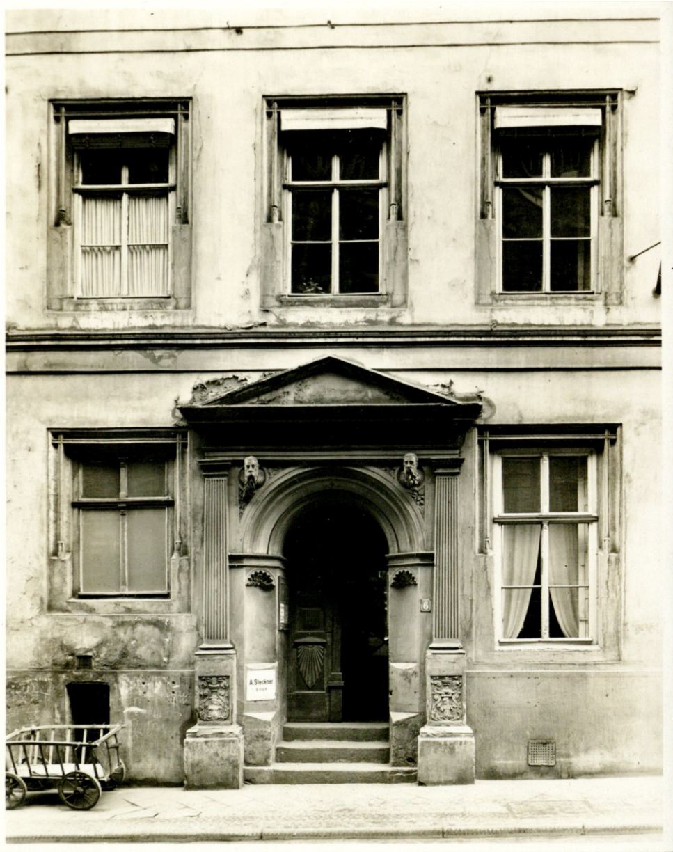
Кућа Јохана Августа Еберхарда у Халеу. Извор: Градски архив, Хале. Wohnhaus von Johann August Eberhard in Halle. Quelle: Stadtarchiv, Halle (Saale).
