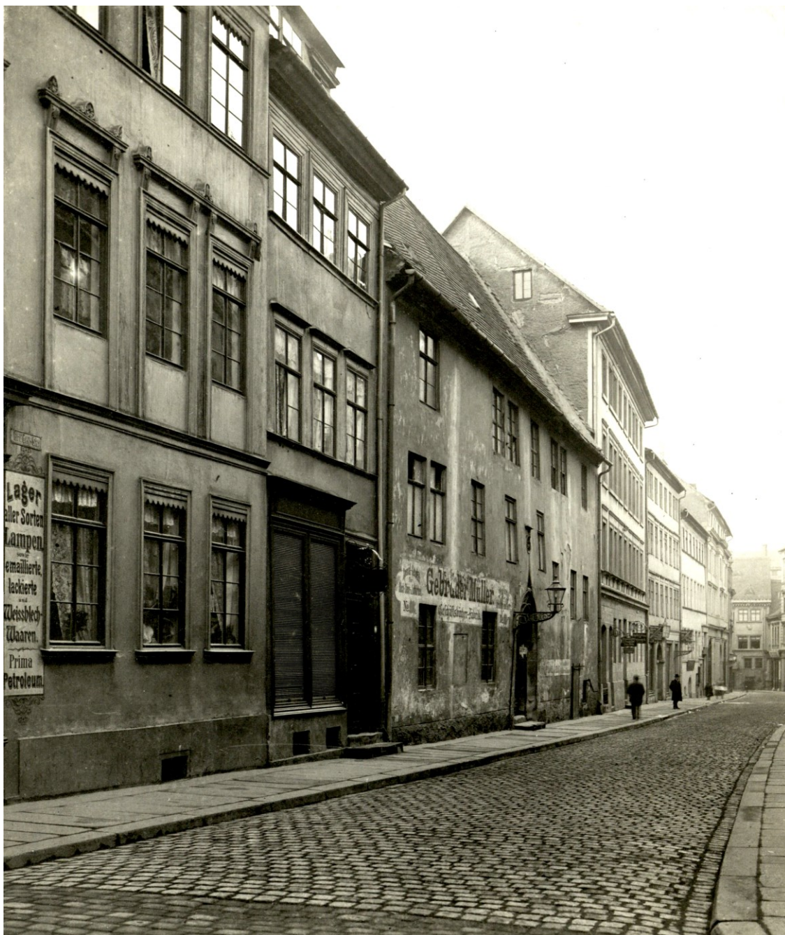
Брудер штрассе – Еберхардова кућа. Извор: Градски архив, Хале. Brüder Straße, das Wohnhaus von Johann August Eberhard. Quelle: Stadtarchiv, Halle (Saale).
