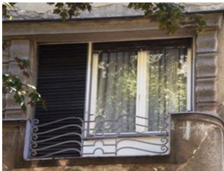
Сл. 1134 1938. Авалска 6 балкон (терен)
