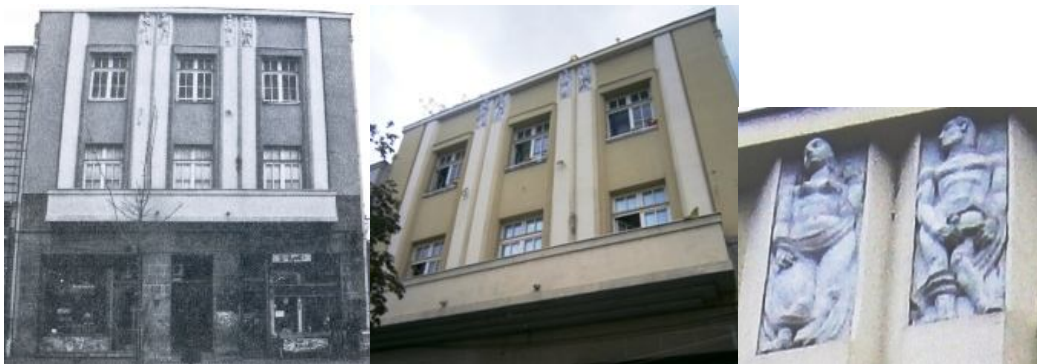
Сл. 2111-2113 1925. Смедерево Трг републике зграда Црквене општине, архитекта Војислав Зађина (сл.2111:Д.Срејић, сл.2112 и в.2113 Оливера Вујасиновић)
