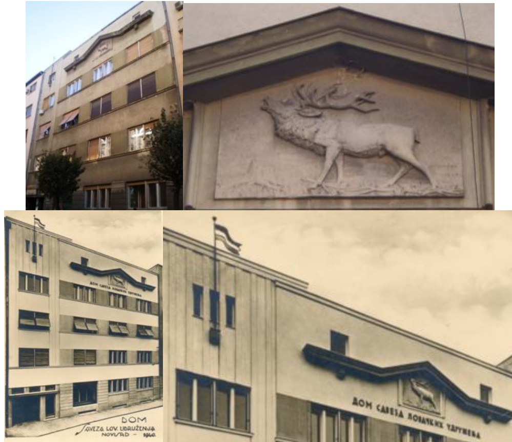
Сл. 2047-2050 Нови Сад Јована Ђорђевића 4 Ловачко удружење (сл.а и б:терен, сл.в и г колекција М. Јуришић)
