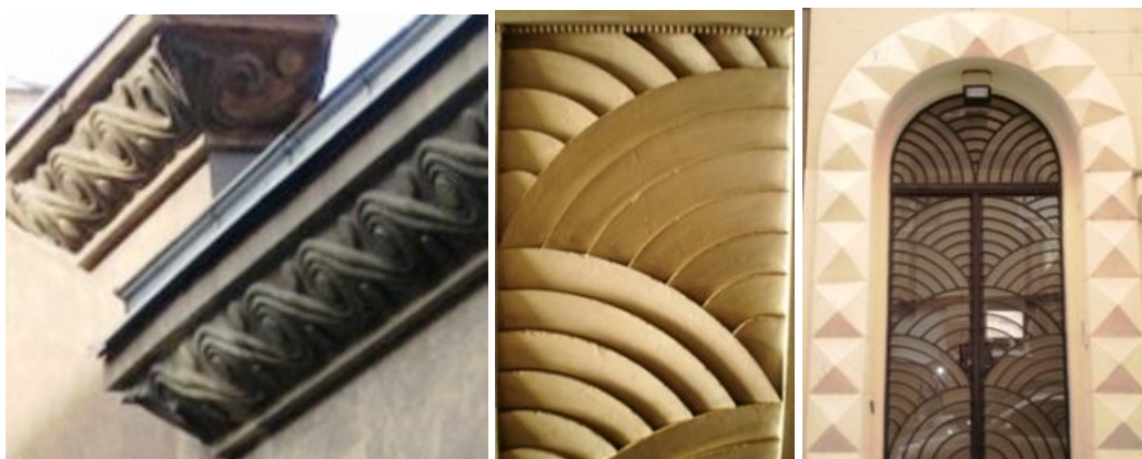
Сл. 111: Кућа Николе Узуновића у Нишу, сл.112: Станоја Главаша 14, сл.113: Алексе Ненадовића 8 (терен)
