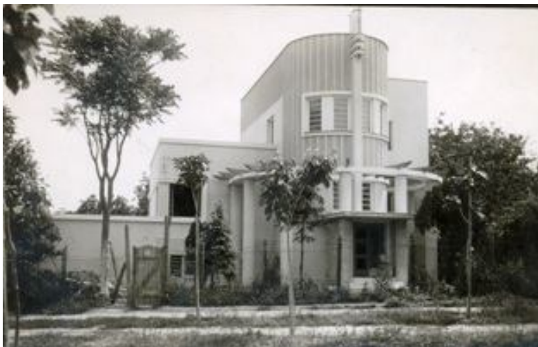
Сл. 829 и 830 1936-37. др Милутина Ивковића 9, порушена, (колекција М. Јуришић)
