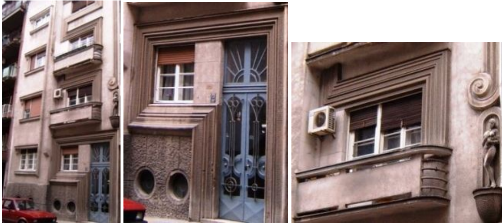
Сл. 1151-1157 1937. Алексе Ненадовића 13 (сл.1151-1153:ИАБ, сл.1154 и 1157:терен)
