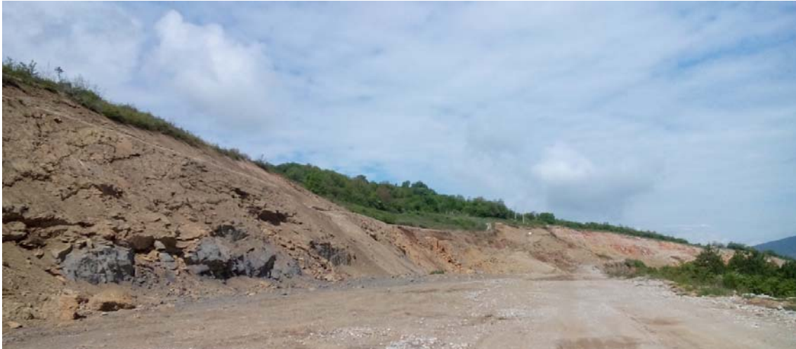
Slika 6.8 Izgled kosine Gradinje km 99+820 do km 100+660 (14.08.2012.)
