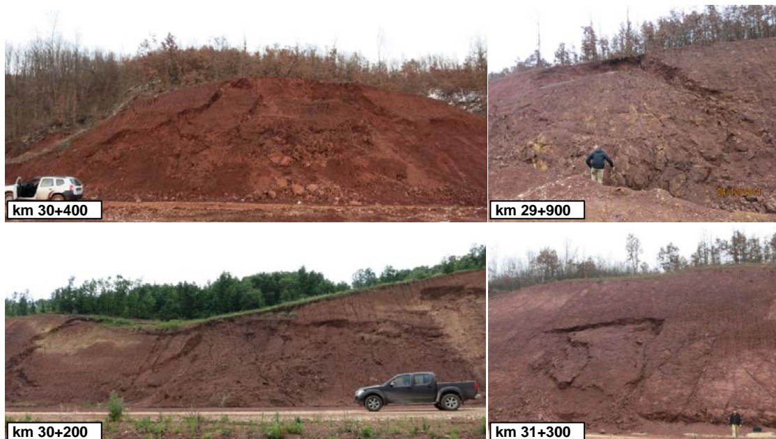
Slika 7.5 Karakteristične nestabilnosti u permskim sedimentima
