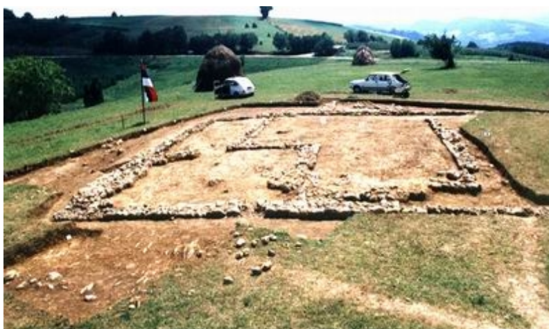
Сл.13/5, Поглед на објекат са истока, документација ЗЗСК Ваљево
