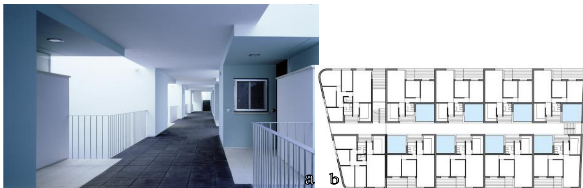
Slika 11: Stambena zgrada, Conil, Španija, Javier Terrados, 1999
