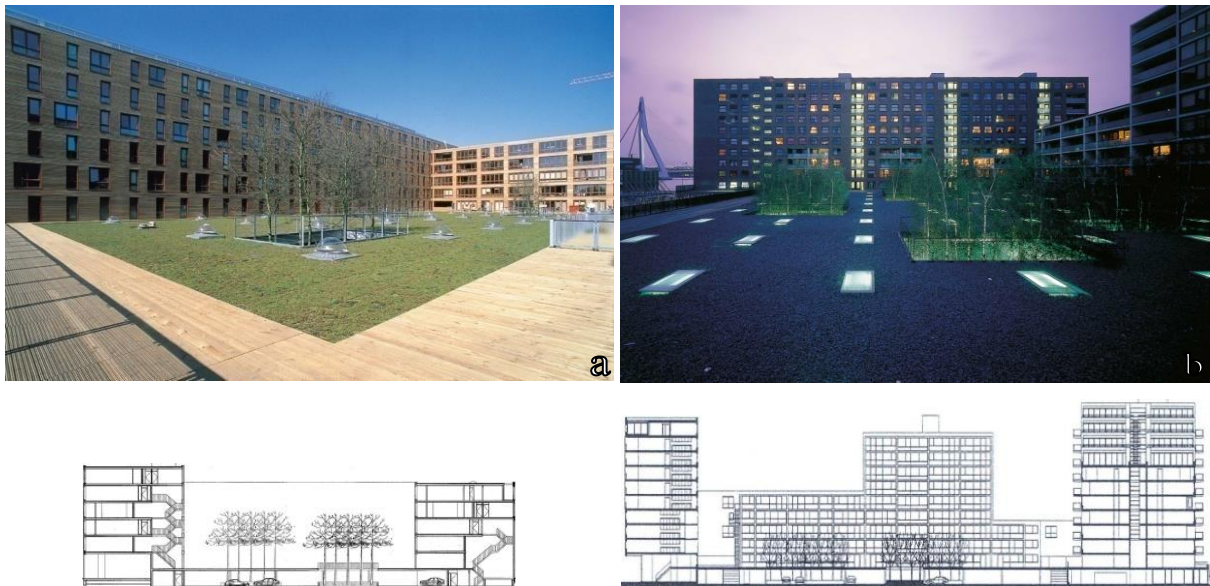
Slika 69: Stambeni kompleks Batavia, Amsterdam, Holandija, de Architekten Cie, 2000 (69a); Stambeni kompleks De Landtong, Rotterdamu, Holandija, de Architekten Cie, 1998 (69b)
