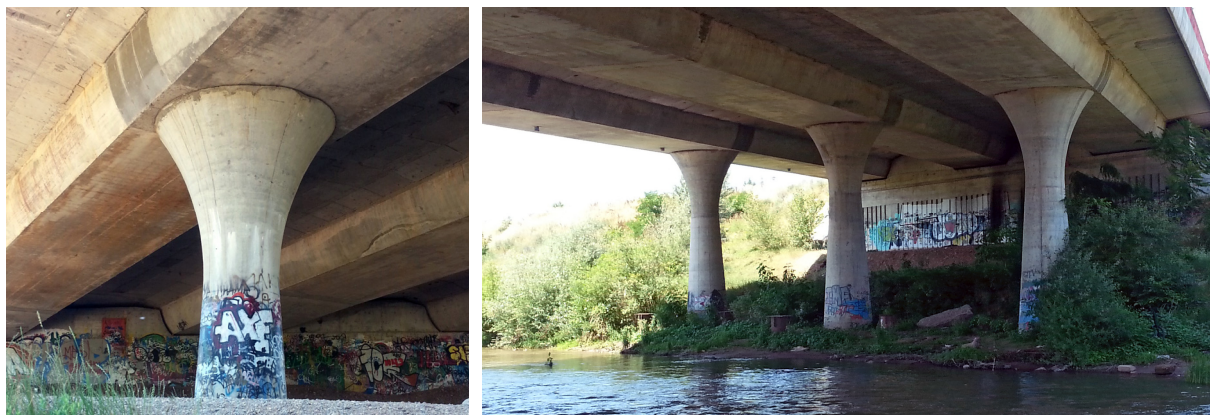
slika 53. Stubovi mosta na Bulevaru Medijana, Niš, Srbija, 2006. /V. Nikolić/
