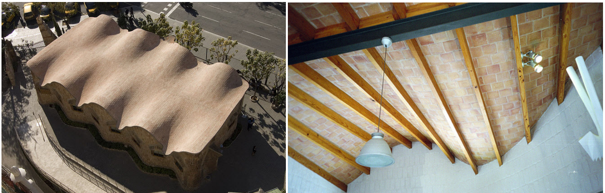
slika 43. Školska zgrada uz katedralu Svete porodice, Barselona, Španija (Antonio Gaudi)
