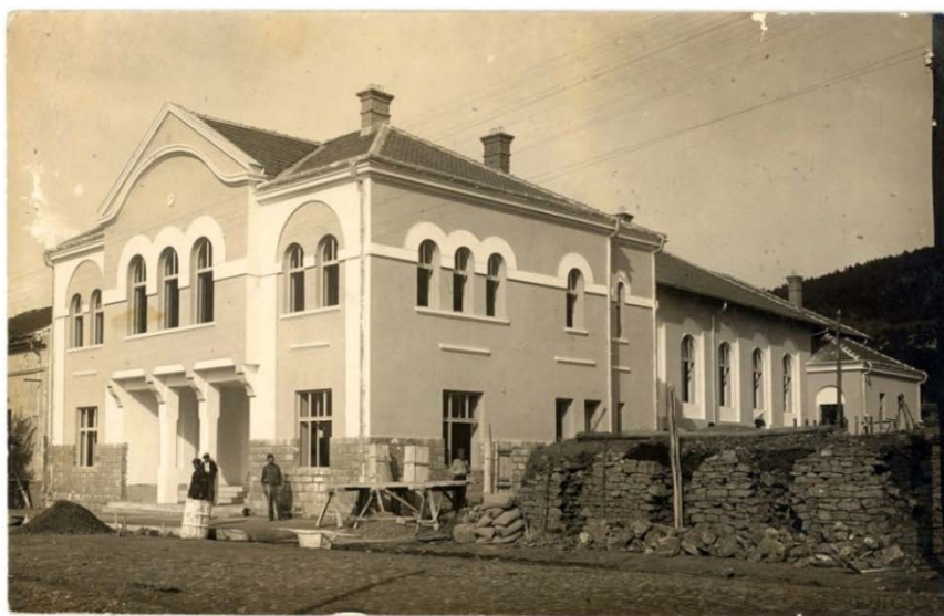
Слика 47 - Момир Коруновић, Соколски дом у Прокупљу, 1933. (колекција Милоша Јуришића)
