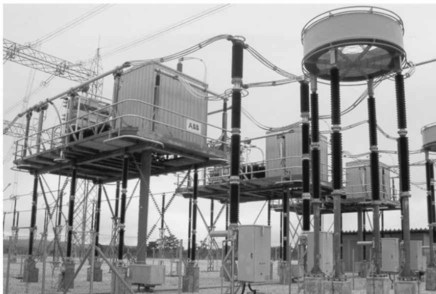
Sl. 2.13. Prikaz postrojenja sa TCSC uređajem
