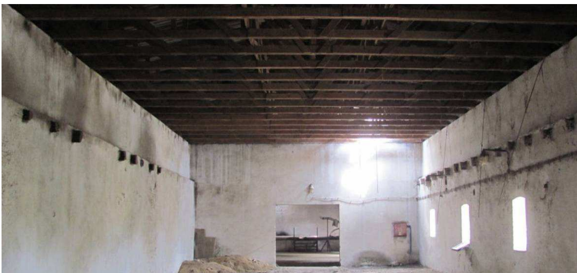
слика 84. дрвена конструкција, 2013.
