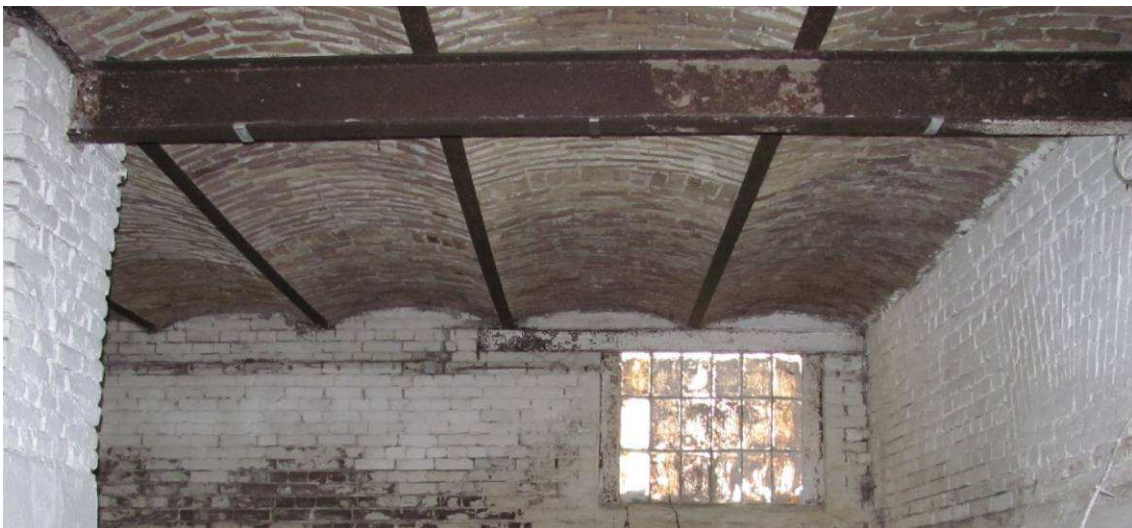
слика 83. примена опеке, зидови и пруска капа, 2013.
