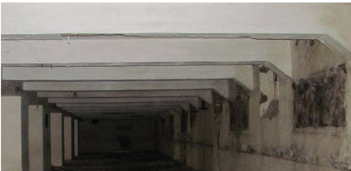
слика 85. бетонска конструкција, 2013.
