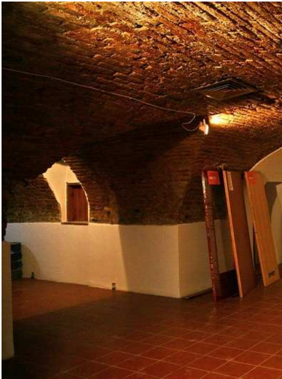
слика 17. сводна конструкција, 2011. (ЗЗЗСКП)
