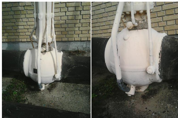
Слика 6.15 Изглед детаља подмазујућих водова
