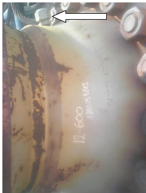
Слика 7.32 Изглед славине пречника 12 colla и класе притиска ANSI 600 са мазалицом за убризгавање ЗМС
