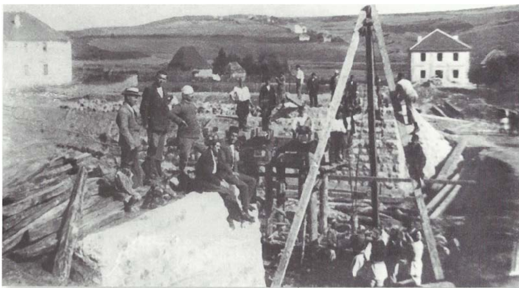
Slika br. 10: Izgradnja mosta na Vidrenjaku na putu Tutin-Novii Pazar
