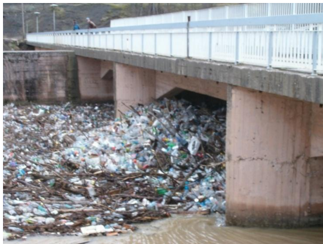
Сл. 68. Површински нанос на брани ХЕ Потпећ (фото: "Дринско-Лимске ХЕ")
