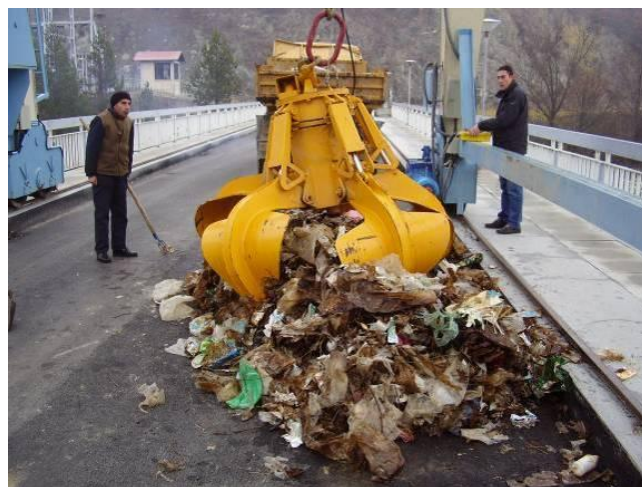
Сл. 69. Извлачење површинског наноса са мамут пумпом на ХЕ Потпећ (фото: "Дринско-Лимске ХЕ")
