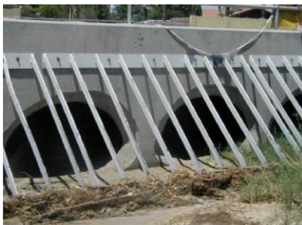
Сл. 11. Решетка на изливу отпадних вода (НЕС, 2005)
