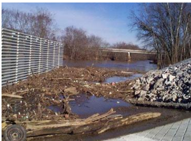
Сл. 13. Комбинација ланчанице и полупропусне преграде (НЕС, 2005)
