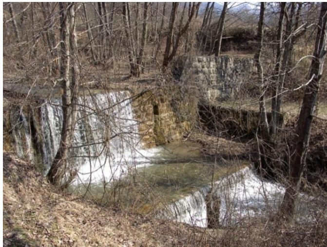
Сл. 14. Бујична преграда запуњена наносом (фото: непознати аутор)
