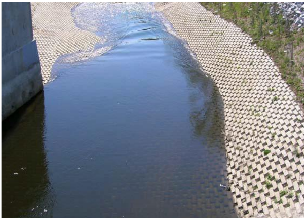
Слика 37. Везани бетонски блокови (AECOM Environment Westford, 2010)
