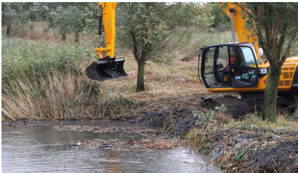
Слика 32. Радови на измуљивању Јегричке ( www.ekourb.vojvodina.gov.rs )
