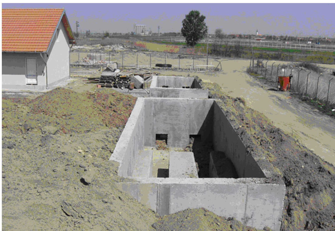
Слика 31. Постројење за пречишћавање отпадних вода (шахт са грубом решетком и песколов) Ковачица ( http://www.hiding.co.rs )
