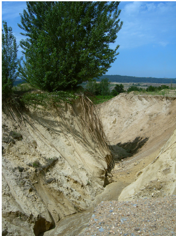
Slika 2.3 Erozija deposola pod uticajem vode
