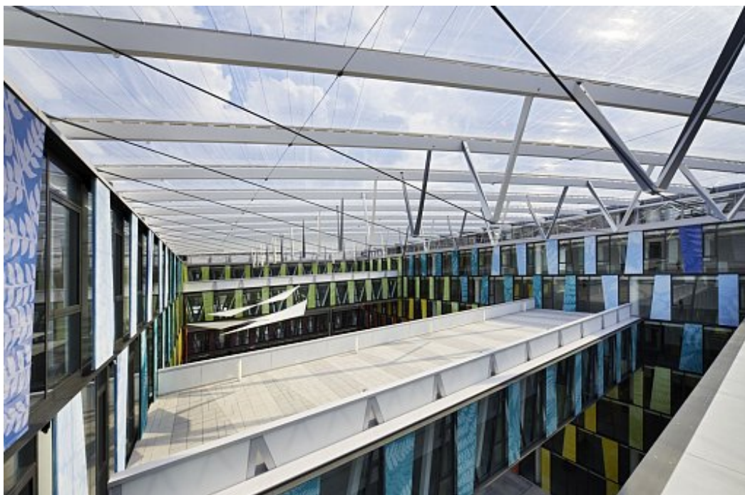
Слика 16. Покривач атријума од транспарентне ETFE фолије која формира ваздушне јастуке изванредних термоизолационих својстава, објекат Amazon Court , Праг. Извор: http://respekt.ihned.cz/75-1557930--1194370-R00000_gallery-3e
