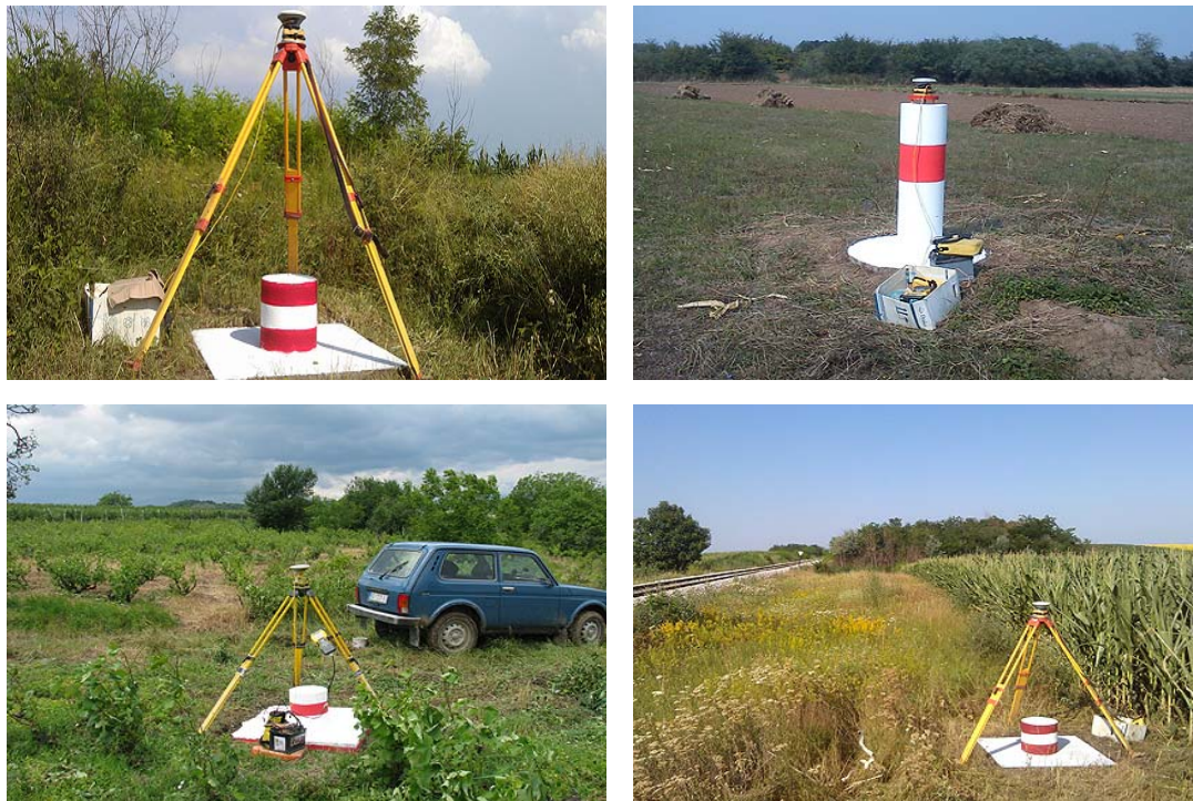
Slika 7.1. Stabilizacija tačaka SREF mreže (Republički geodetski zavod, Beograd)
